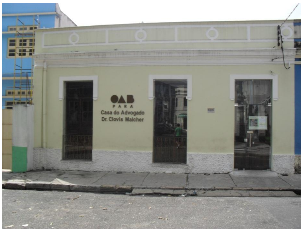
Foto 4: Casa do Advogado Dr. Clovis Malcher, da Ordem dos Advogados do Brasil (OAB). Localizada no Largo de São João, a casa funciona em uma edificação restaurada e inaugurada pela OAB no dia 17 de setembro de 2008. Fonte: Castro, 2011.
